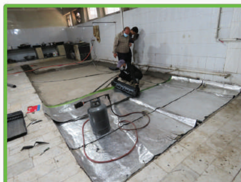
بازسازی بخشی از آشپزخانه نیروگاه
