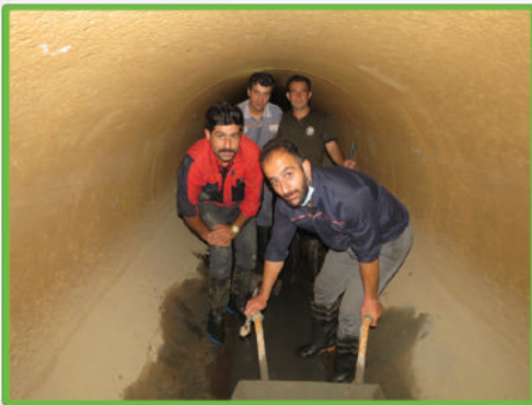
نظافت لوله خروجی آب برج خنک کننده به کندانسور
